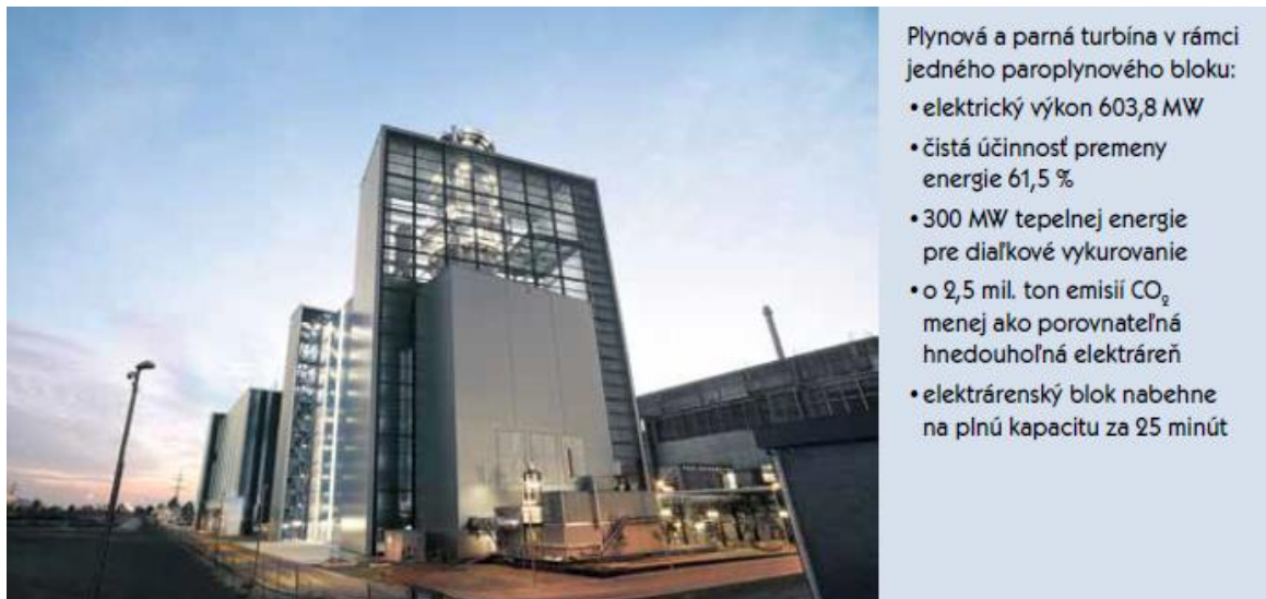
Obr. 5 Stadtwerke Düsseldorf FORTUNA (projekt a turbíny SIEMENS), v prevádzke od januára 2016. Najefektívnejšia a najekologickejšia paroplynová elektrárňa na svete.
